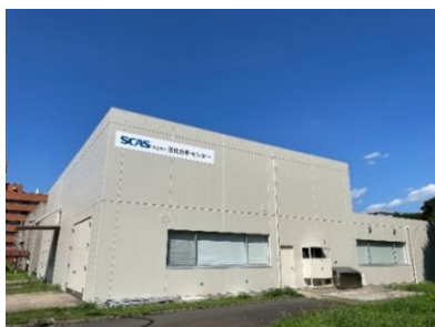
筑波サテライトラボ外観（4-7棟）
